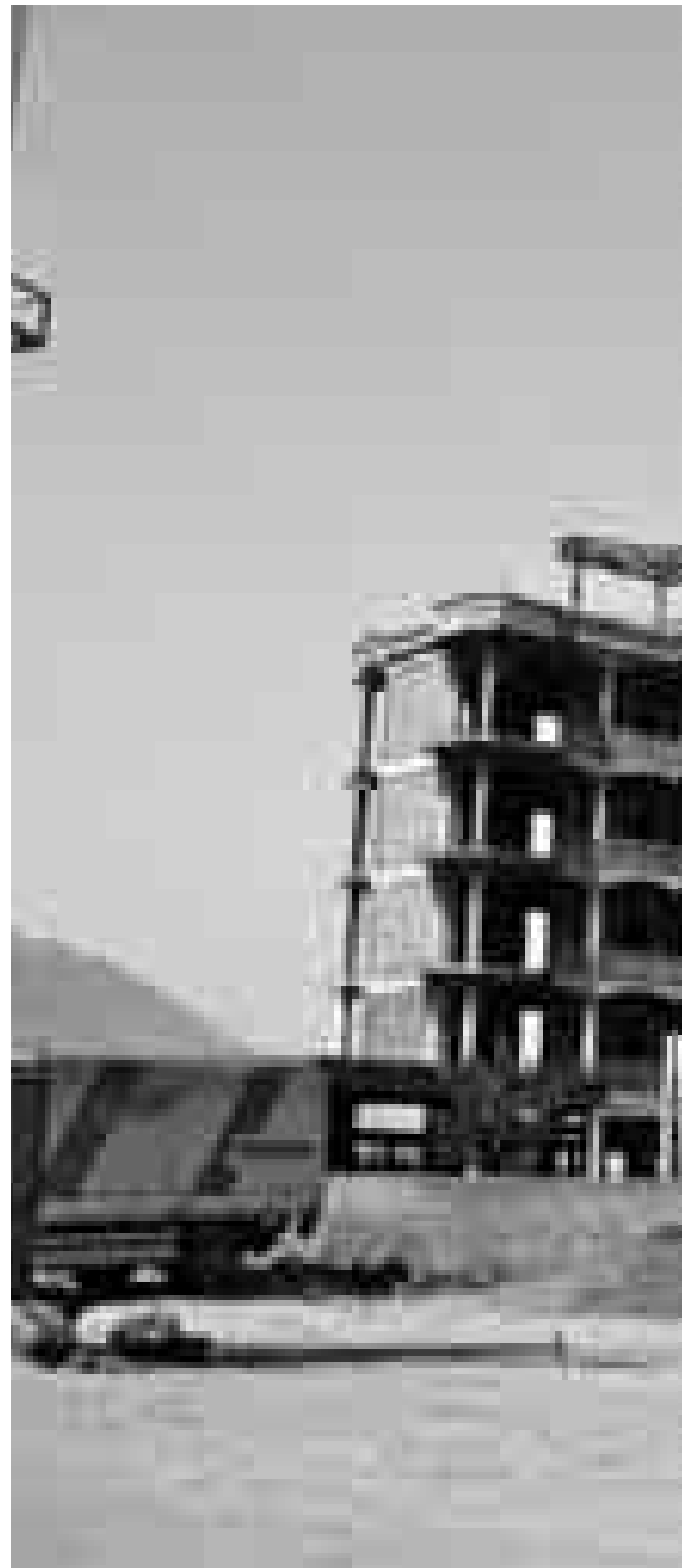
Rohbau in Shkodër zwischen Tirana und Podgorica, Azra Aksamija
